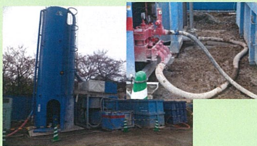
コンクリートミルクが放出される杭機の先端部分
