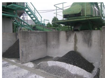
その1 工場の様子や材料の保管状況等を確認する。
