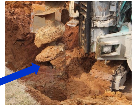
コンクリートミルクが放出される杭機の先端部分
